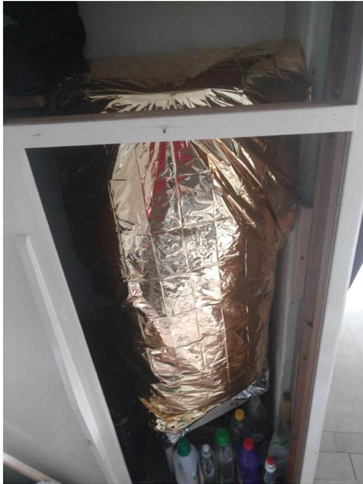
FIGURE 4 – Photo de la capote isolante pour chauffe-eau installée chez Aurélien.
