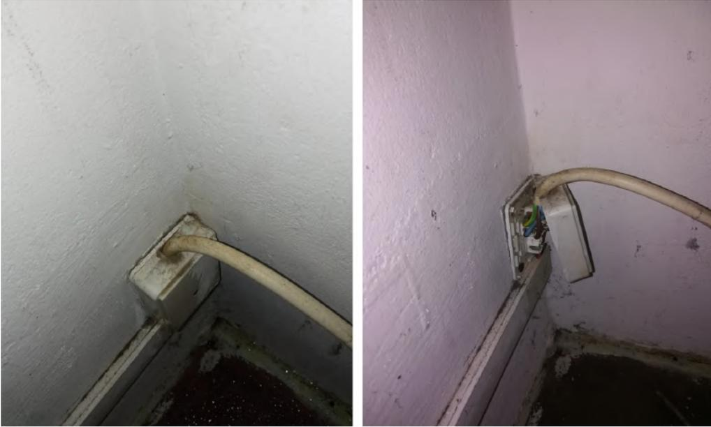
FIGURE 12 – Photo de la prise de courant du chauffe-eau cellée (gauche) et ouverte (droite). Auteur : Rémi Jouët-Pastré.
